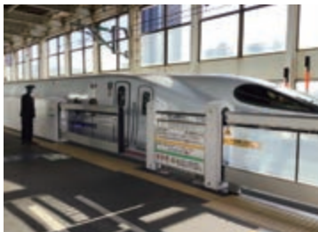
ホーム柵の整備（山陽新幹線 広島駅）
