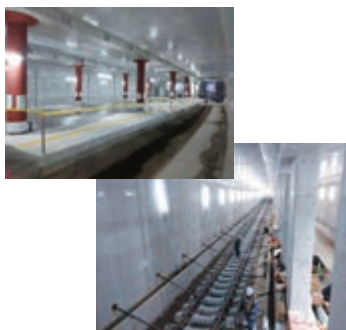
東海道線支線地下化・新駅設置工事
