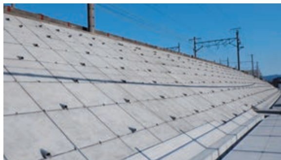
斜面防災工事の実施
