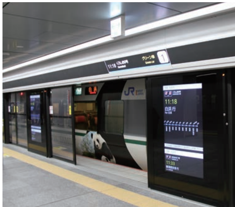
大阪駅（うめきたエリア）の「顔認証改札機」（左）と世界初のフルスクリーンホームドア（右）
