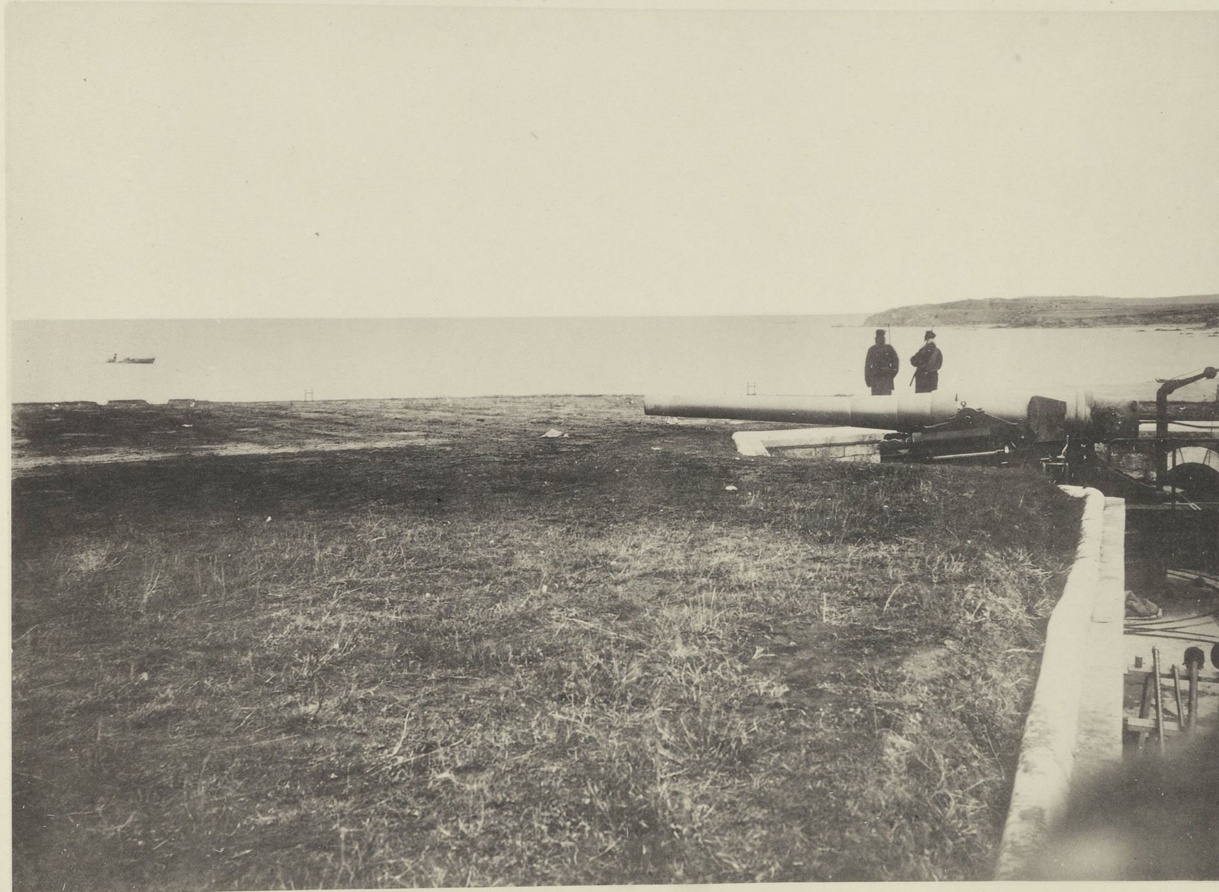
況狀ノ沒沈號二十二第艇雷水我及部一ノ臺砲嘴廟龍岸東ノ港衛海威 ナ益砲嘴角鹿ノ嶼島ノ面前テニ徑口五十三番一廿式克ハ砲備 影撮日二十月二年八廿治明
