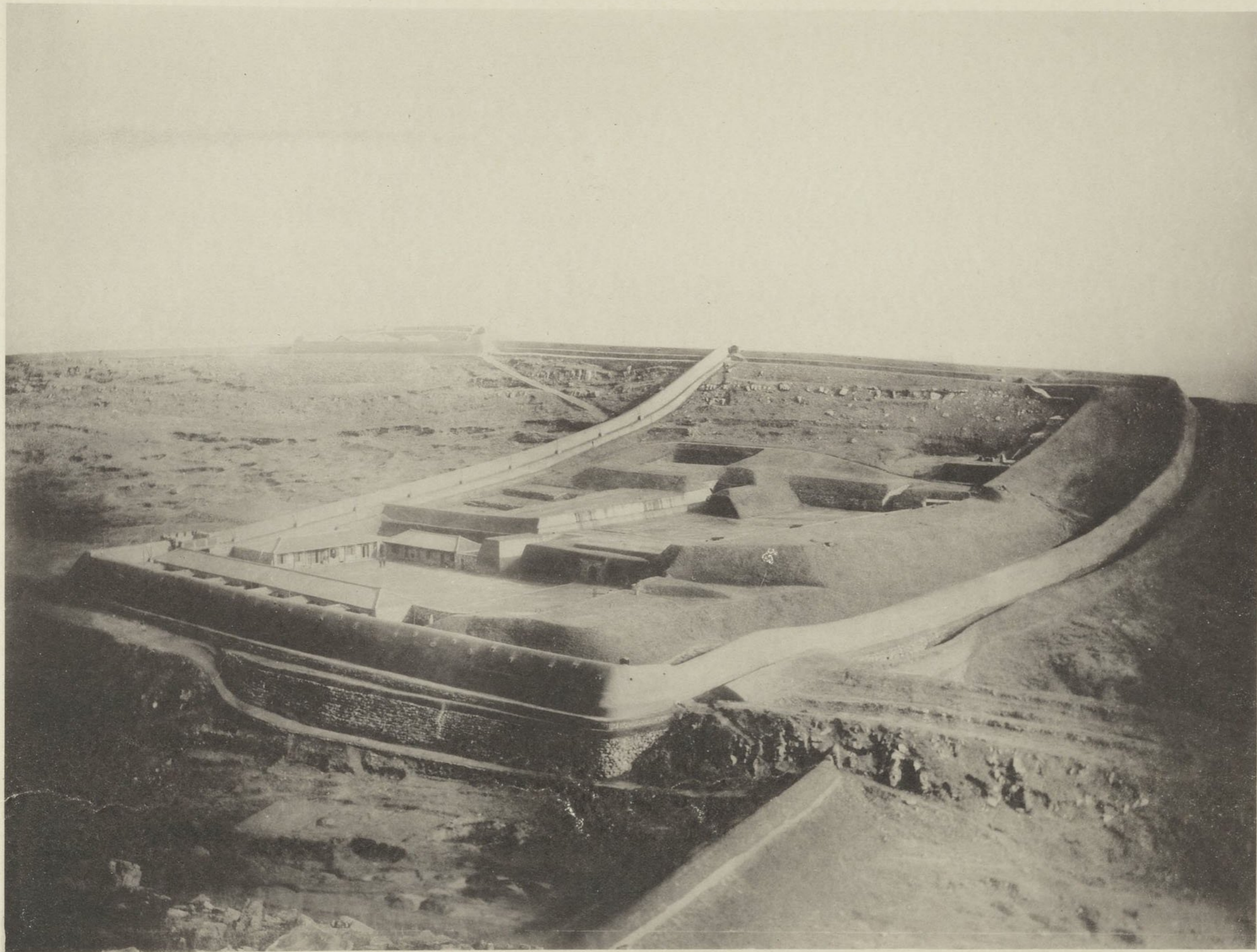
(一其) 景光ノ等營左兵親及、臺砲諸ノ子蠻、頭饅、頭城口順旅 燈電・物藥建ルアニ部上方後ノ台砲全リナ徑口五廿珊八式克・門三ノ砲備ルアニ側右ノ牆胸大テシニ台砲山頭饅ハルナ方右 ルセ有ノ郭圍ノ形矩ノ方左、台砲子蠻ハ部起隆ノ方左其、坐燈電ルタルニ顯リニ陰側左其、台砲山頭饅ハ所ルアノ竿旗、坐 リナ台燈ハ所ルアノ屋白ニ方上其、營副子慶ハルニ見ノ壁白ニ方上、營左兵親ハ 影撮日八十二月一十年七廿治明
