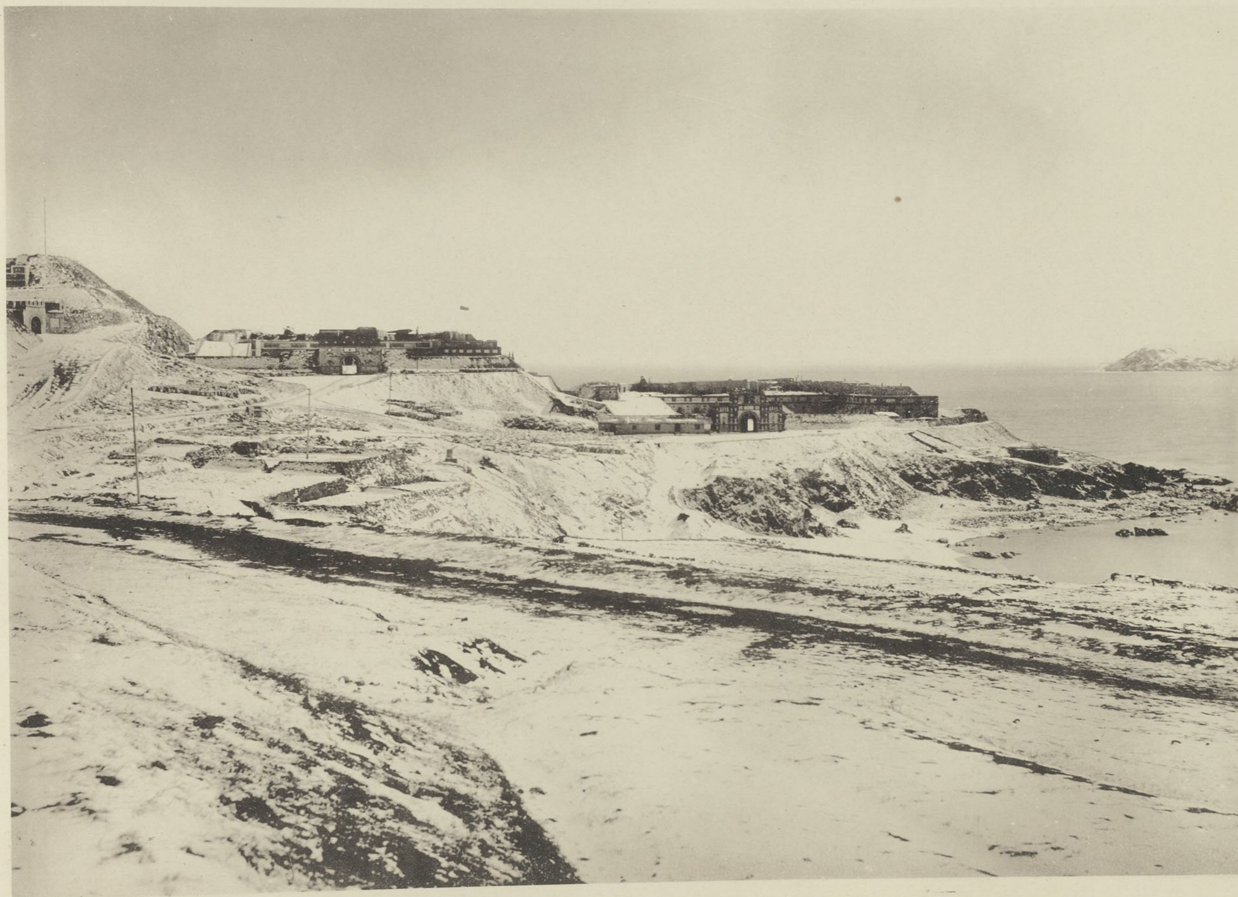
(一其) 景全ノ臺砲嘴山北岸西港衛海威
