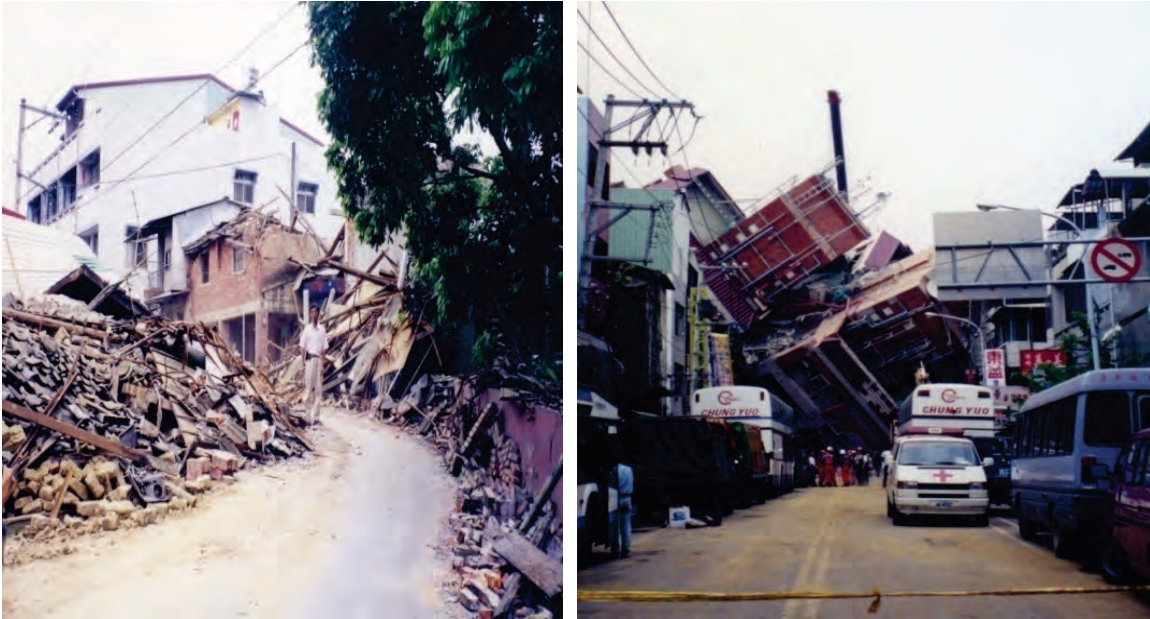
上圖：921 地震台中東勢地區民宅受損嚴重。
