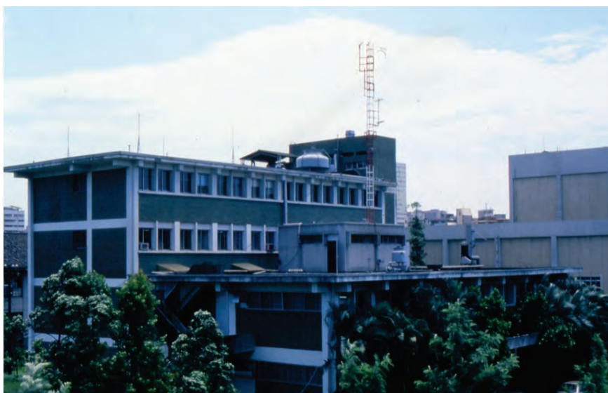
本所籌備處後棟四層樓建築
